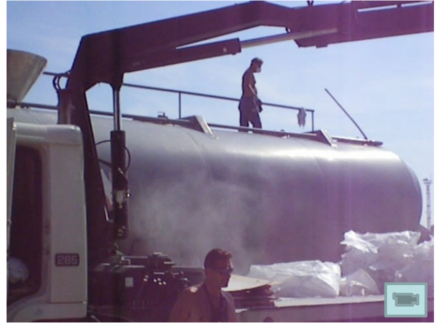
4. Nettoyage de la citerne : jet d'eau + rouleaux
